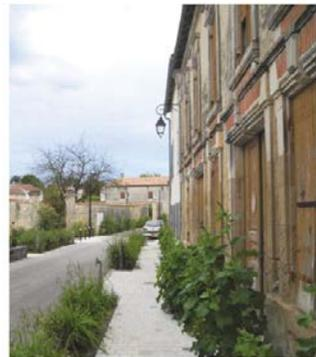
Plantations en limites de trottoirs, voirie, permettant la récupération et le tamponnage des eaux pluviales
