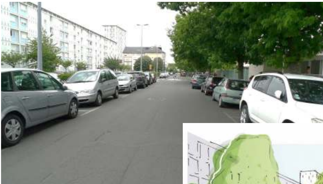
EXISTANT – Rue Baugé
