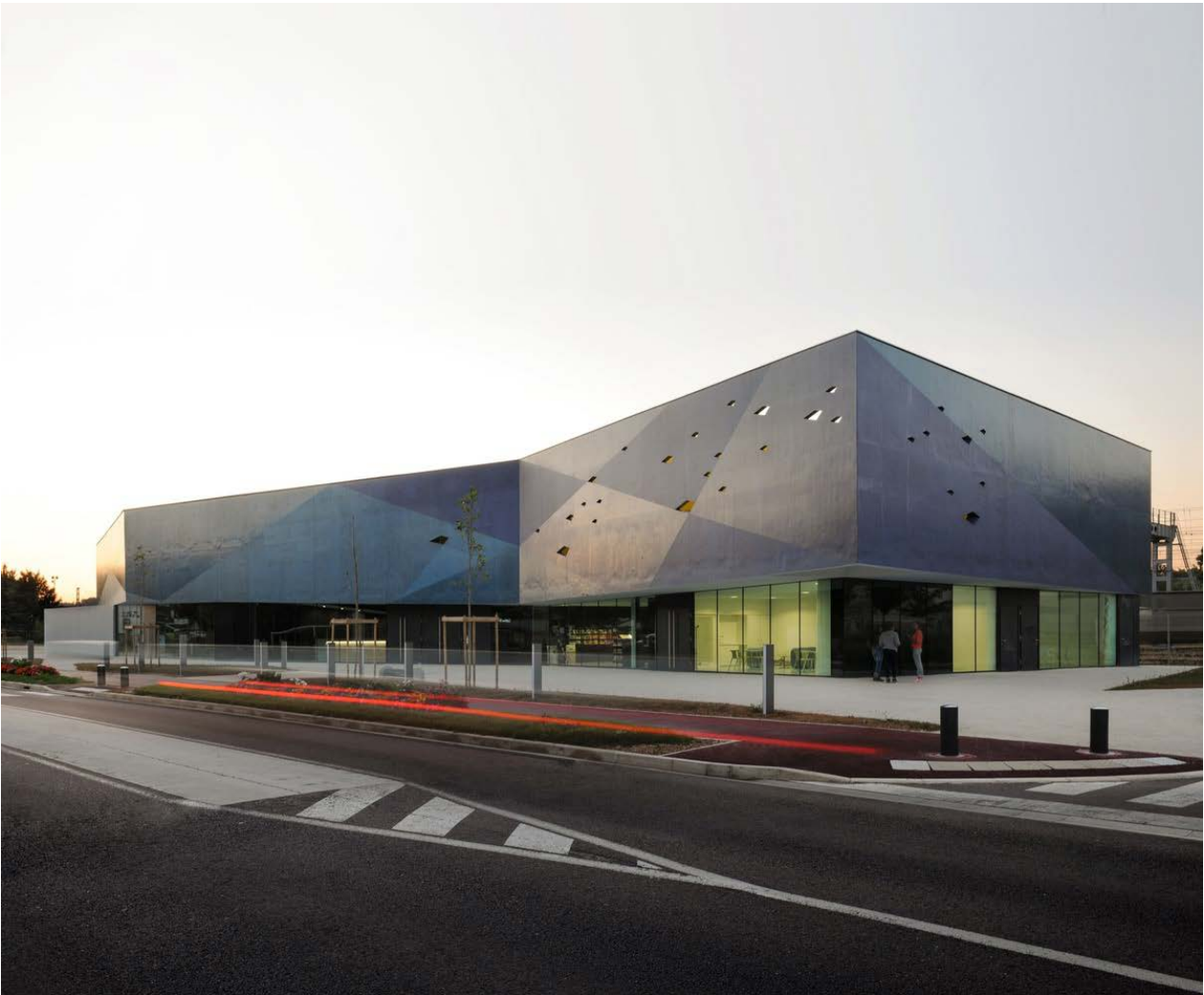
Centre d'art et de congrès, Pôle Intergénérationnel et Office de Tourisme à Venarey-Les Laumes _ Dominique Coulon & associés
