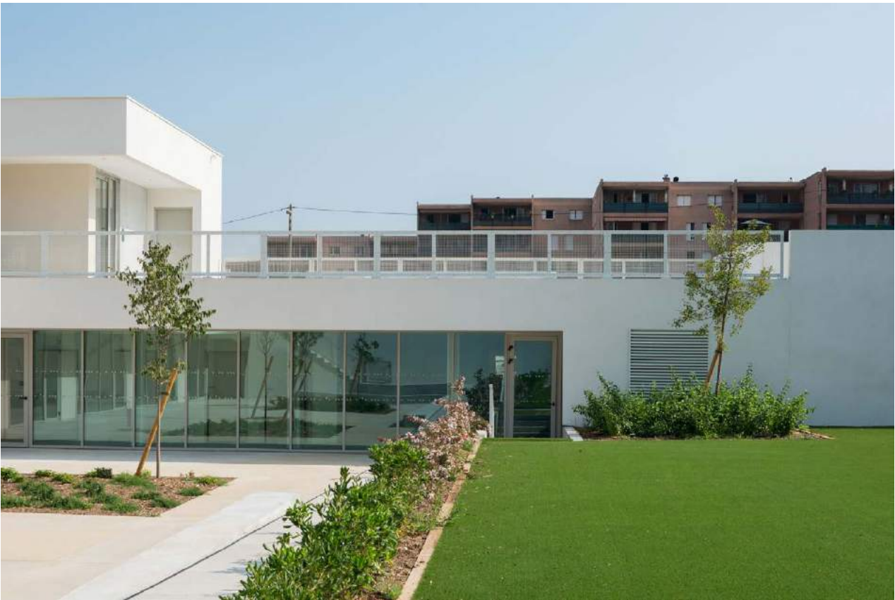
Maison de quartier La Cayolle _ M+N Architecture
