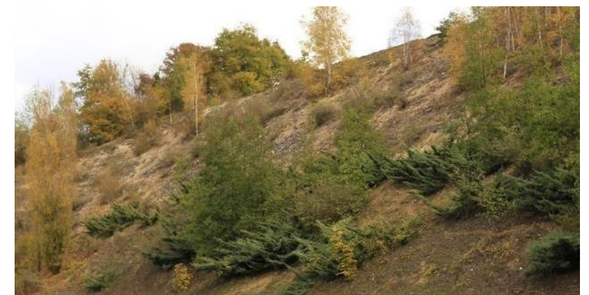
Talus de remblais planté de végétaux adaptés à la sécheresse
