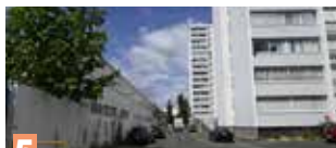
5 Conserver l'accès à la dalle de la résidence du Grand Mail par l'escalier et la rampe
